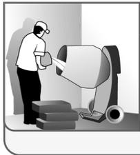
**Mezcla en Betonera (trompo mecánico):** Incorpore al equipo un 60% del total del agua de amasado. Luego agregue Adilisto Pega Enchape y, revolviendo continuamente, incorpore el agua de amasado faltante. Mezcle durante un minuto y medio hasta lograr una mezcla homogénea.
